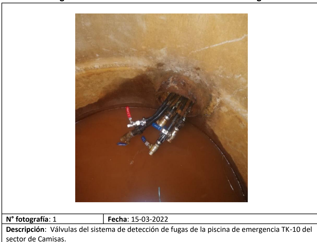
Figura 2. Válvulas del sistema de detección de fugas
